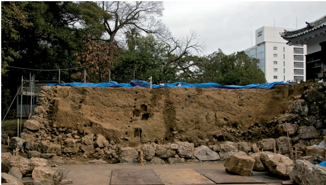
写真24 追手門東北矢狭間塀西面石垣解体状況
