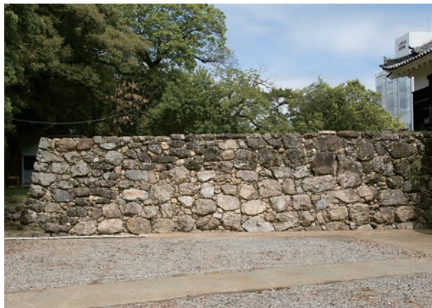
写真25 石垣整備完成
