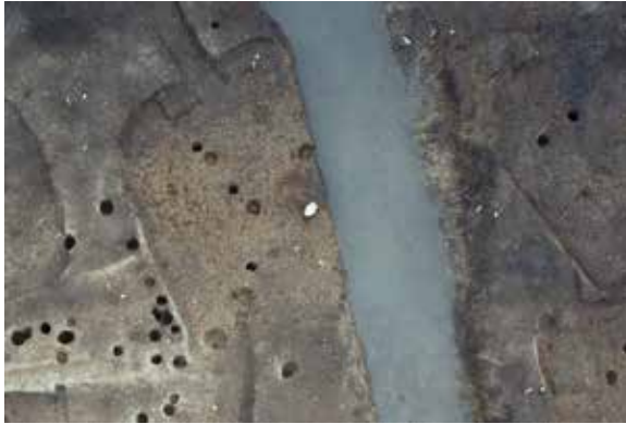
ST52・大溝完掘状態(上空より)
