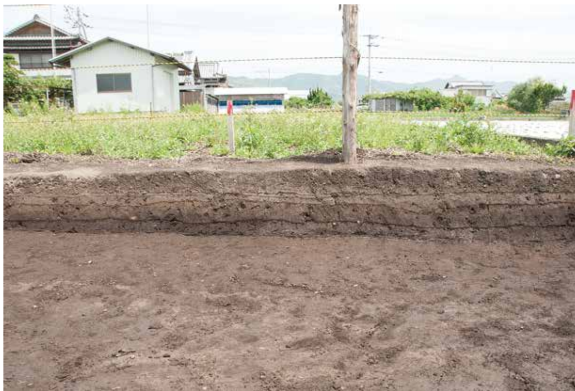
調査区北壁セクション(南より)
