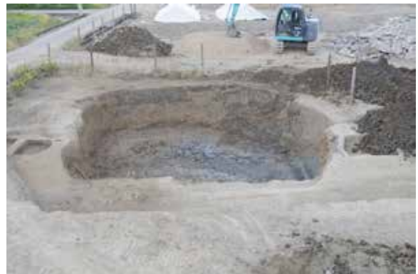
Ⅱ-1-3区 SK1完掘状態(西より)
