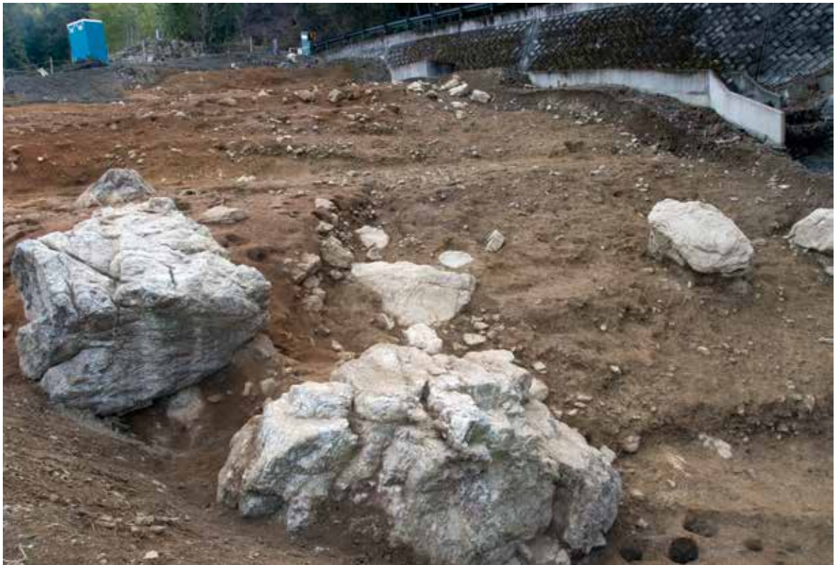
SR1 完掘状態(北東より)
