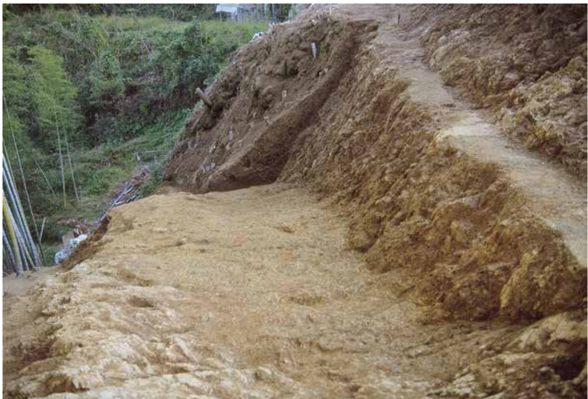
I n 区遺構完掘状態(北西より)
