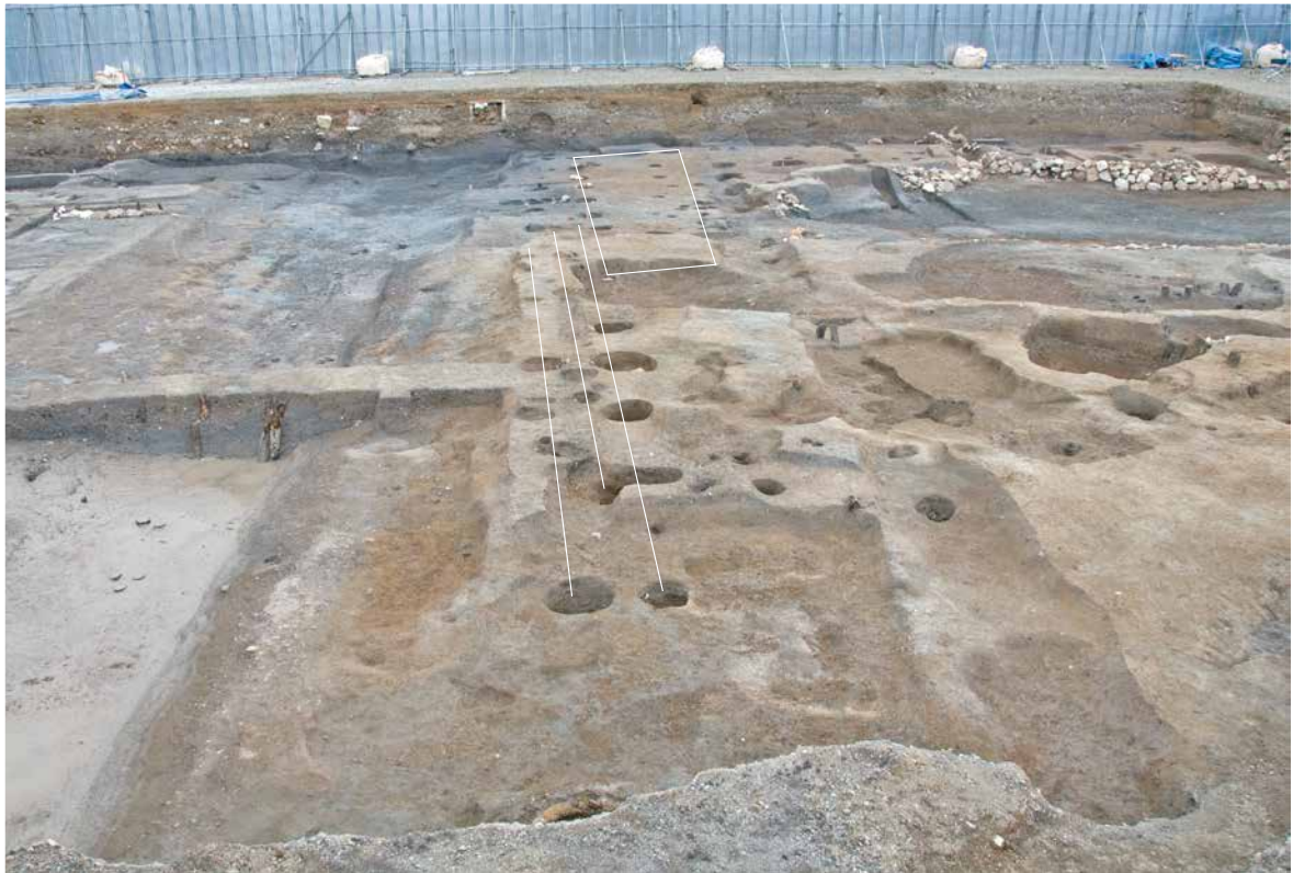
A-1区SB-201, SA-201～203完掘状態(北より)
