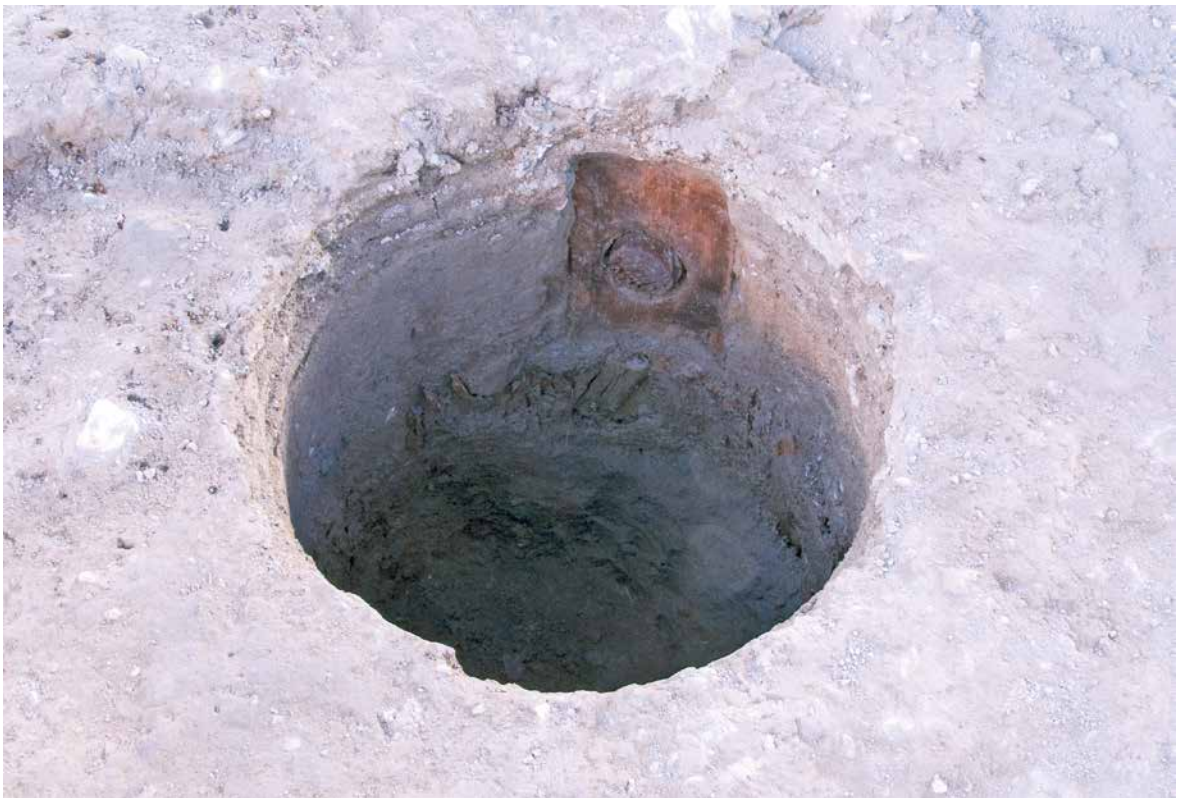
B-1区SK-232集水桶継手(2036)検出状態(南より)
