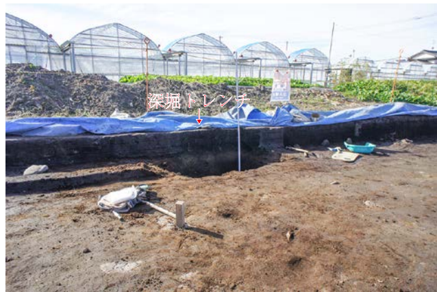
写真2 調査区南壁沿いの深掘トレンチ掘削位置 (5地点)
