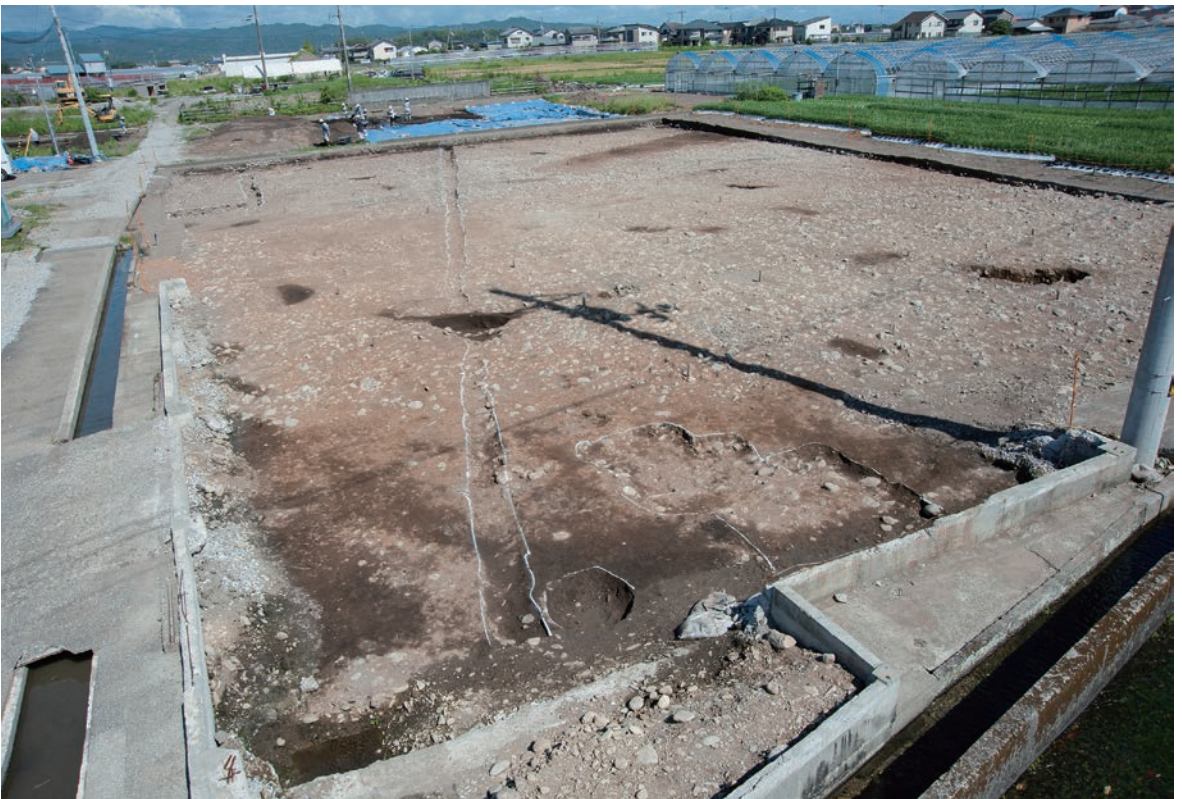
遺構完掘状態(西より)
