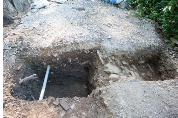
トレンチ3西端・拡張トレンチ(東より)
