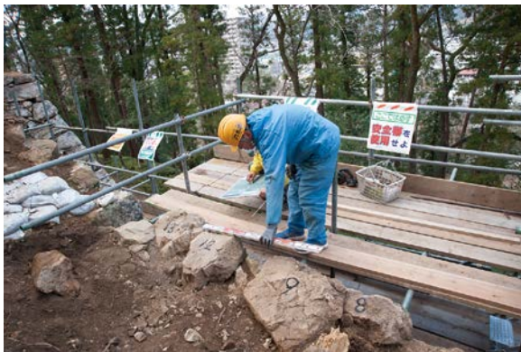
築石計測作業(南より)
