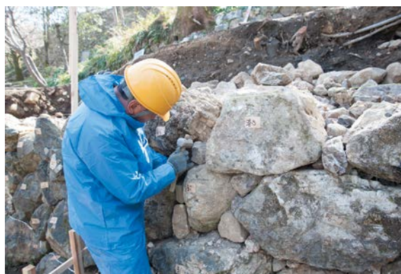
写真11 築石間の間詰め作業
