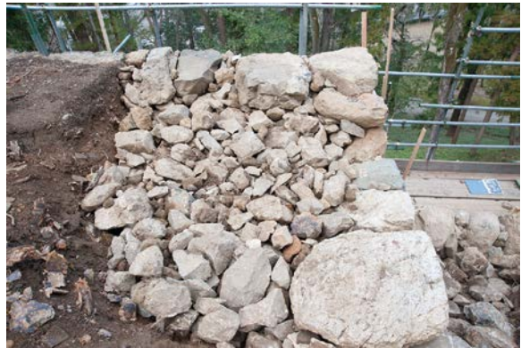
入角天端栗石充填状態(南より)
