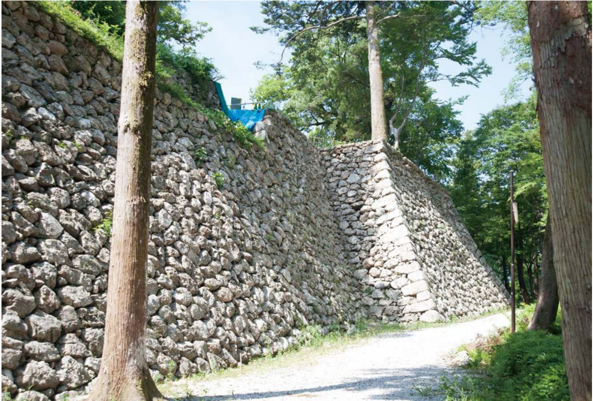
梅ノ段北側石垣解体前風景(北東より)
