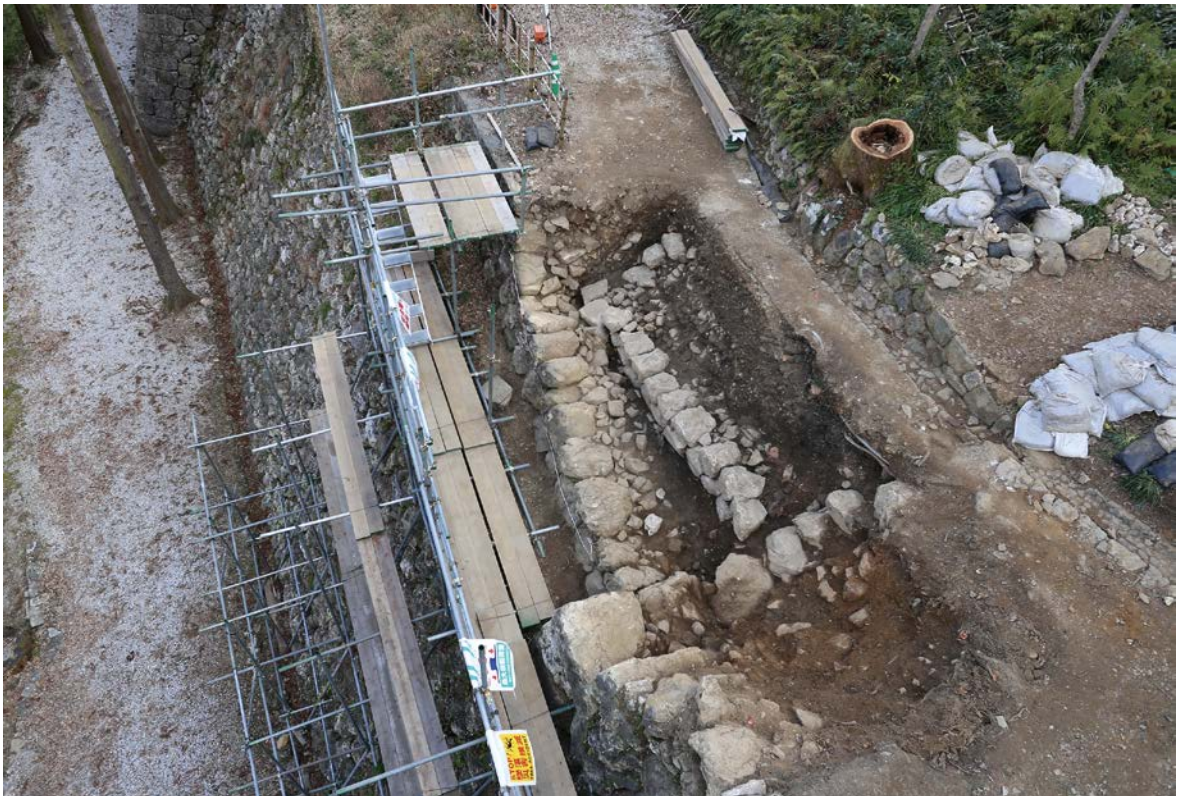
解体最終面及び石積み検出状態（北西より）
