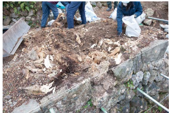
天端木根の除去作業(北より)
