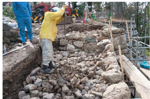
写真9 栗石の充填作業
