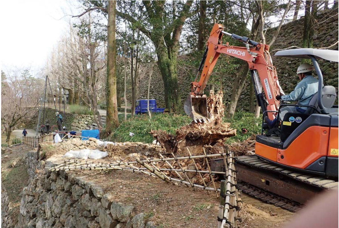
倒木の除去作業（北西より）
