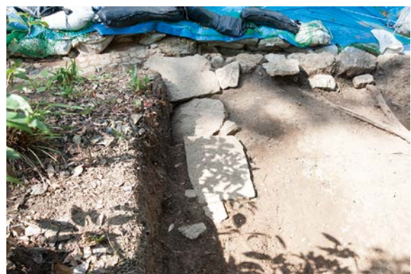
トレンチ2礎石検出状態(南より)
