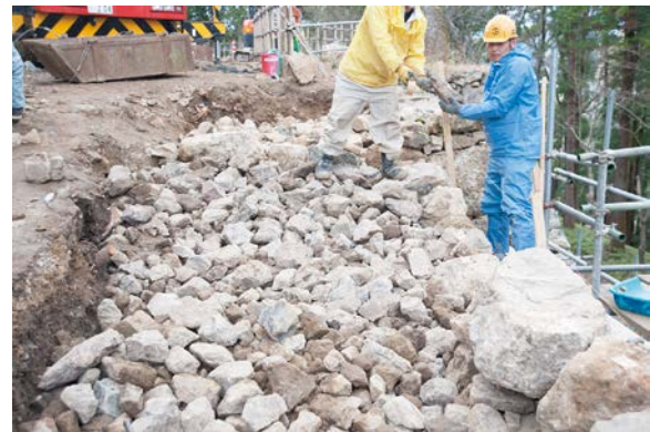
写真8 丁張りの確認作業
