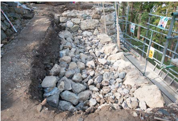
①ライン築石と栗石充填状態(東より)
