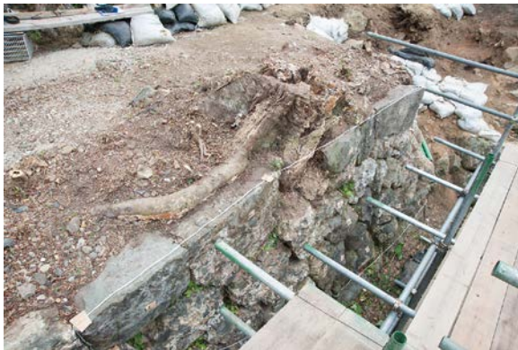
天端解体前木根繁茂状態(北東より)
