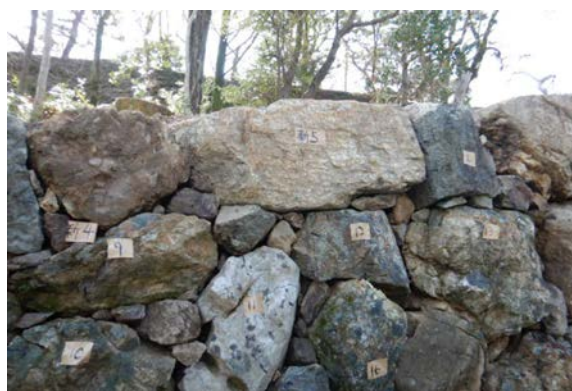
写真12 天端新補石配石状態
