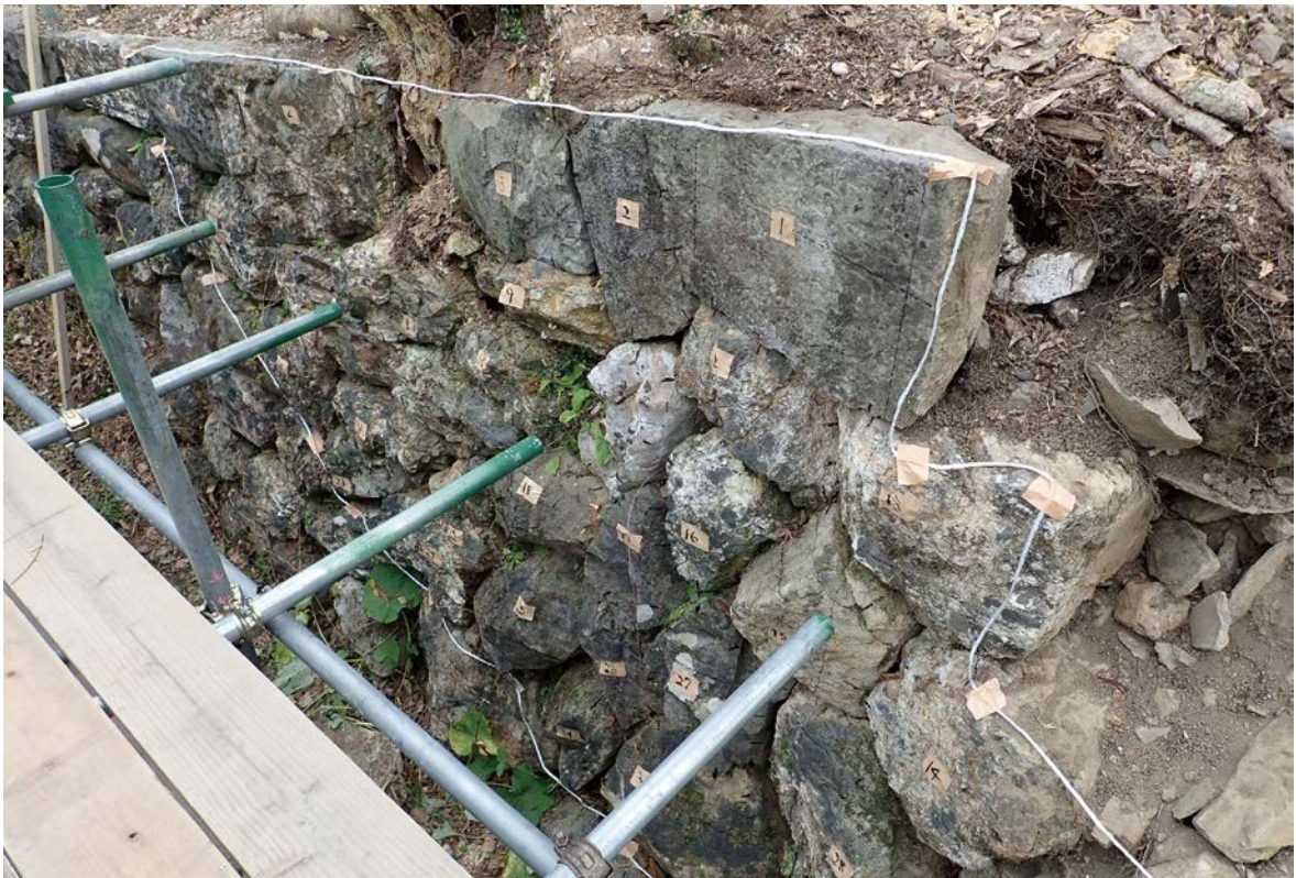
解体石垣番付・墨付の状態(北西より)
