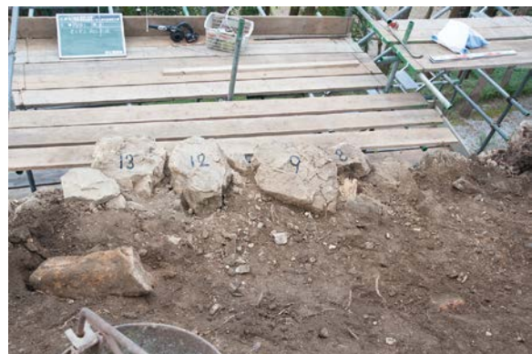
解体2段目築石と栗石の状態(南より)
