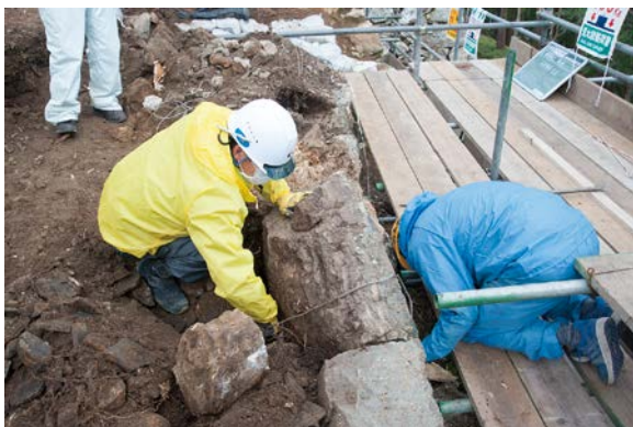
築石解体作業(東より)
