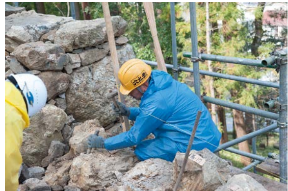
写真7 築石の微調整
