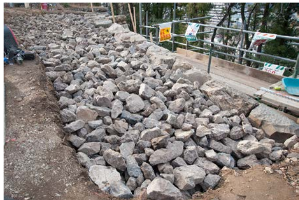
天端石と栗石の充填状態(南東より)
