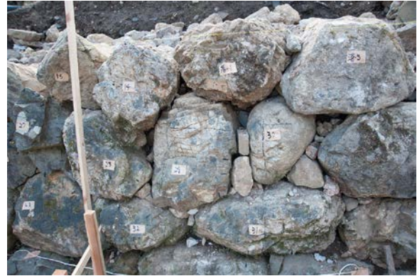
写真6 落石と解体築石の配置
