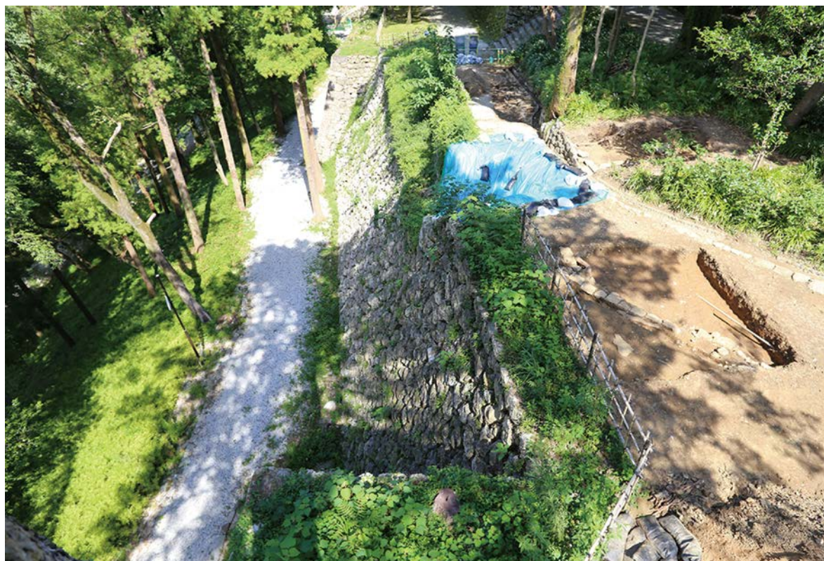
トレンチ完掘状態及び梅ノ段北側石垣(北西より)
