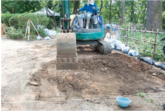
トレンチ1重機掘削(東より)
