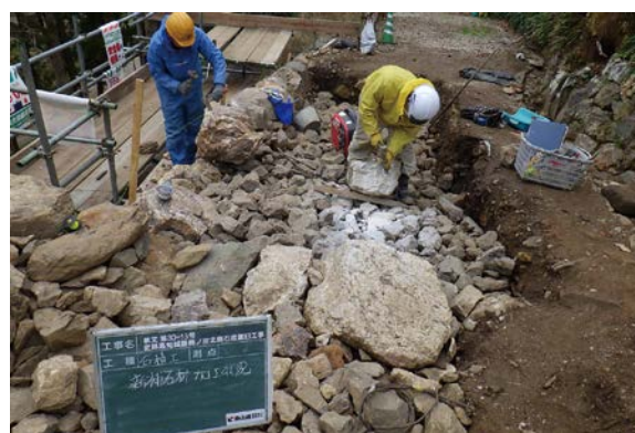
写真3 新補石加工作業
