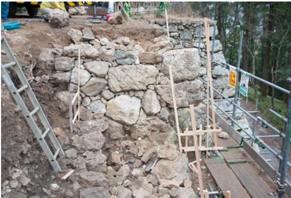
入角積み直し状態(東より)
