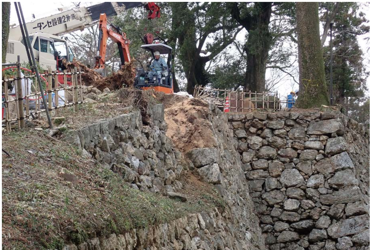
倒木の除去作業（東より）
