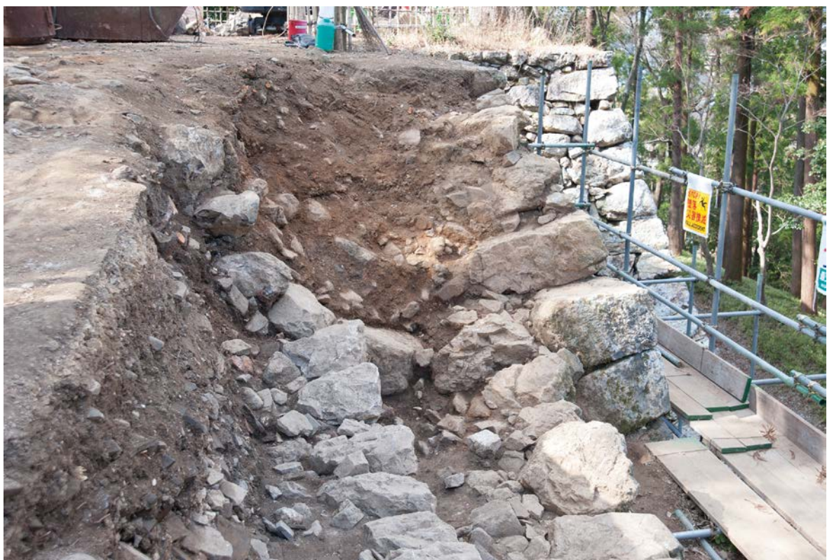
解体完了及び入角検出状態 (東より)
