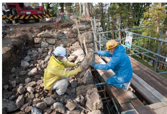
写真4 築石積み直し作業
