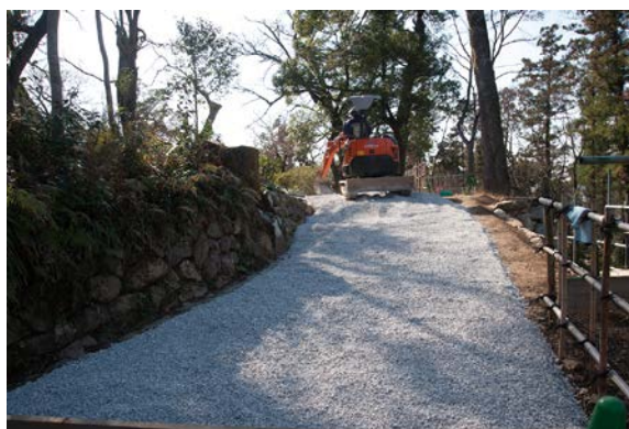
写真13 天端の保全・景観整備作業
