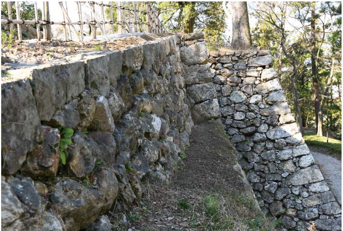
写真15 積み直し完了写真(東より)
