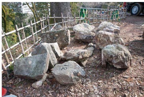
写真2 解体築石保管状態
