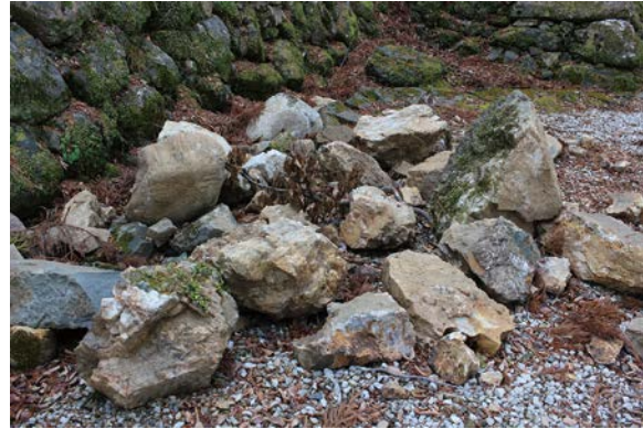
写真1 石垣崩落状態
