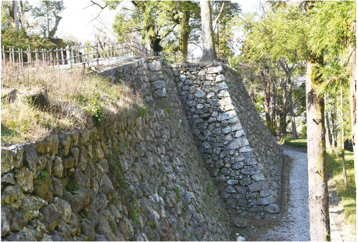
写真14 積み直し完了写真(東より)
