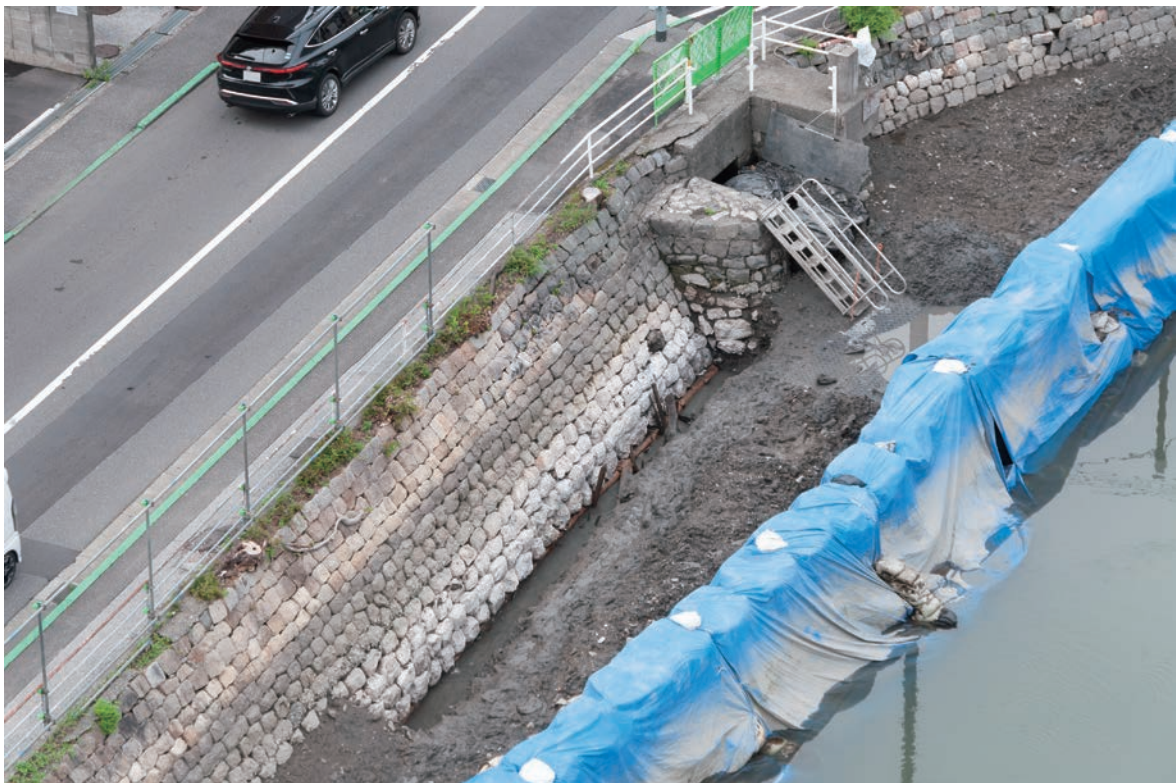
写真47 新堀川西岸石垣(南東より)
