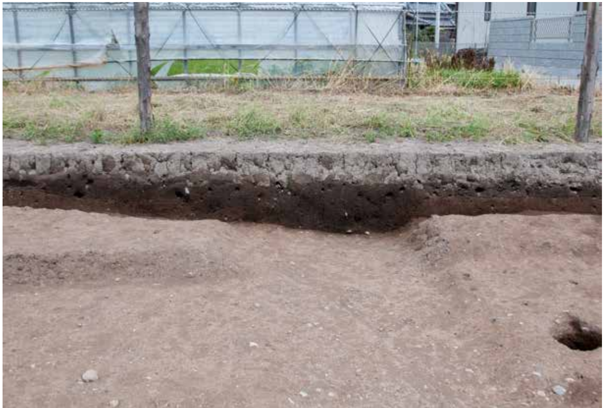
調査区中央北壁セクション(南より)
