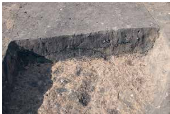
SK238セクション(東より)
