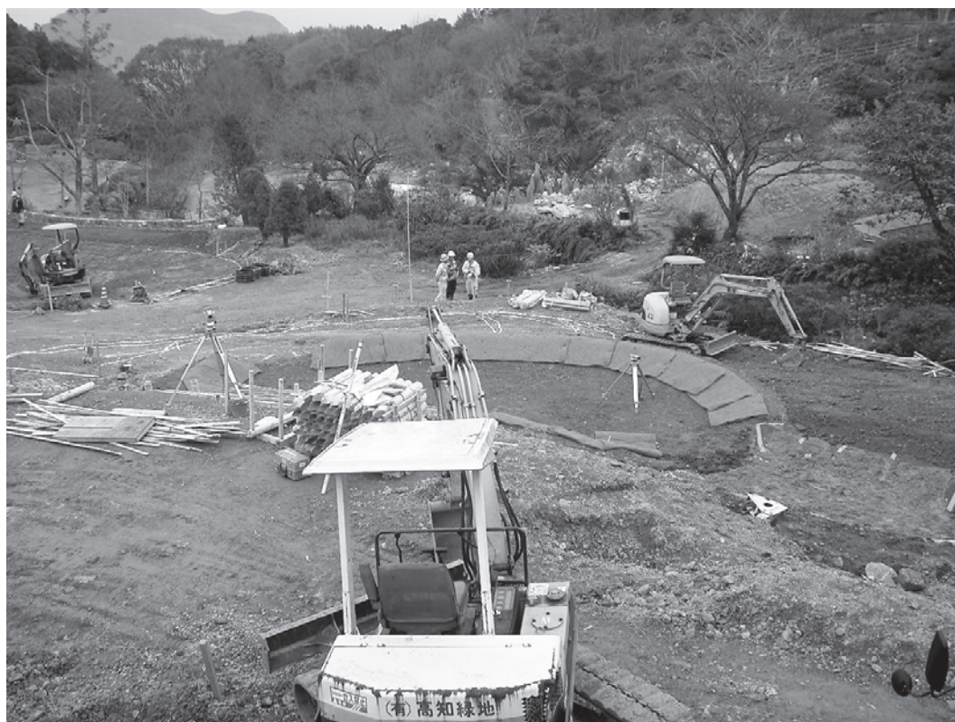
施工状況(1区北西より)
