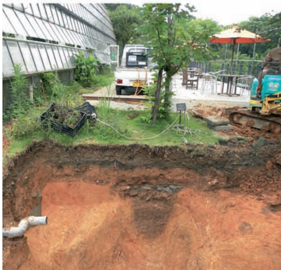
8区土層断面（南から）
