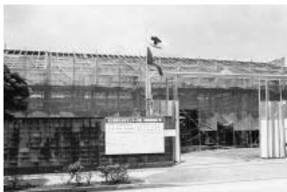
建築の進む本館
