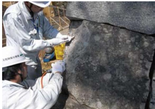
欠損している部分にエポキシ系樹脂と石材を粉末状にしたものを練りこんで補い、擬石処理を行う
