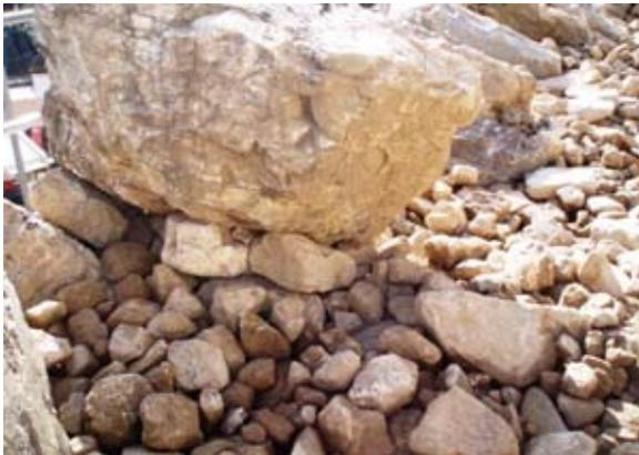
築石の据わりが悪いので、とも介石に加え築石の下に合う介石2石と間石1石で安定させている
