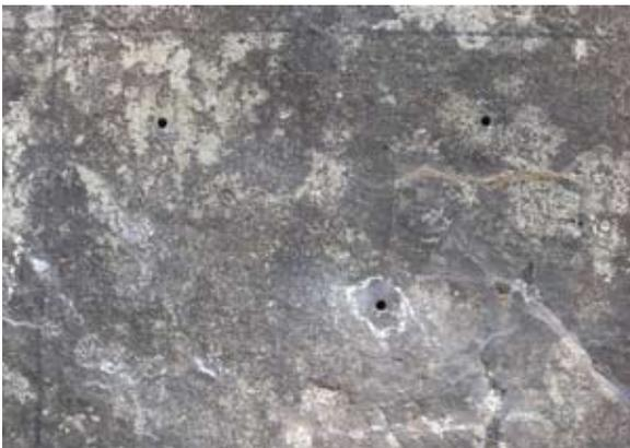
表面内部に空間ができ剥離しそうな部分には、小さく穴をあけ接着剤によるアンカーを打ち込む。表面が剥がれ落ちることがない様に補強する
