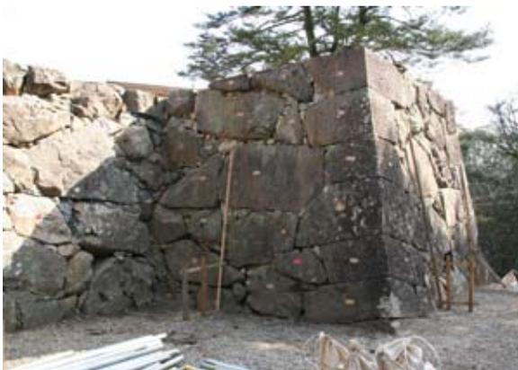
鉄門の積み上げが終了。破石以外の築石は元の位置に納まっている
