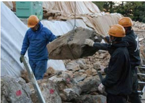
クレーンで築石を天端から積み上げ位置に運ぶ
