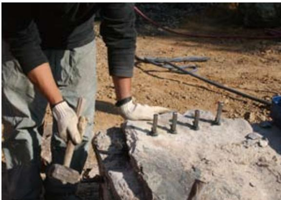
新石を破石と同じ大きさに加工する。写真は、荒割りの様子。割りたいラインに楔を打ち込む
