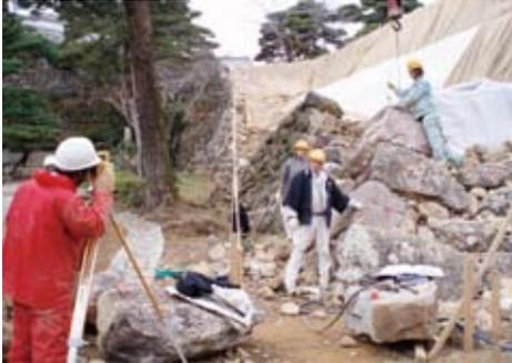
設計の勾配と現存石垣の勾配が一致せず、違和感が生じてしまう事態が発生した。目視上は気付かないように調節するため、平成18年12月12日の専門部会で根石の上の一番石から設計に基づき少しずつ合わせて積みなおすことになった
