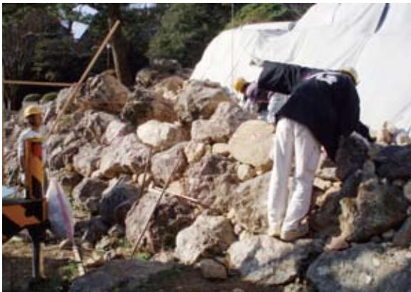
水糸に石面の最前端を合わせる
