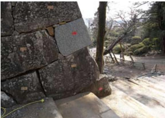
欠損している築石には、擬石処理を施す
