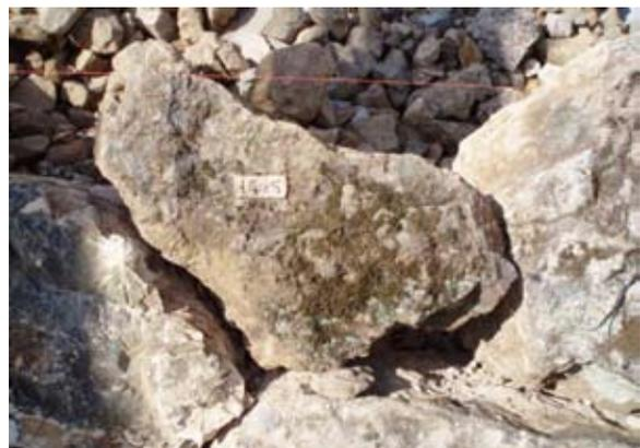
旧石も逆三角形は、左右および下の築石に安定して接しているため、栗石で背面を安定させた後、前から加工した間石を入れる
