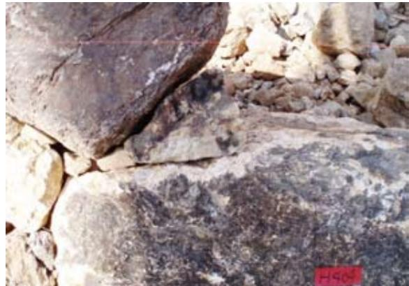
築石の面が逆三角形になっているので、間石を三角形に加工して安定させている
