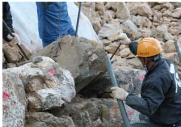
手作業で築石の座る位置を調整していく
