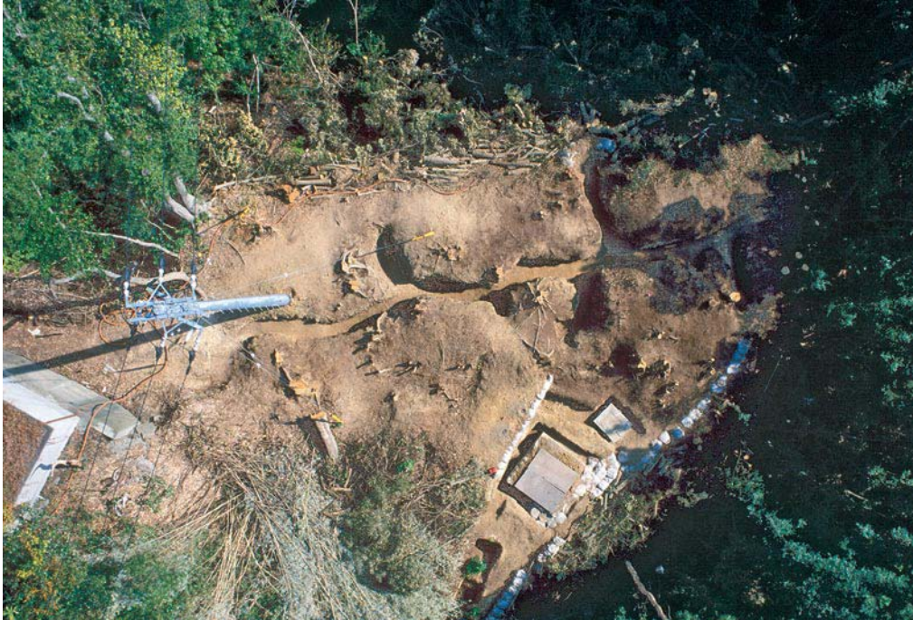
塹壕完掘状況
