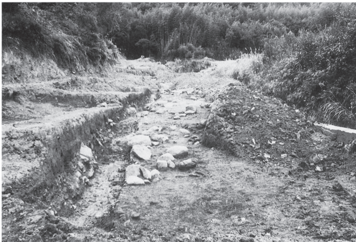
Ⅲ区検出状況
