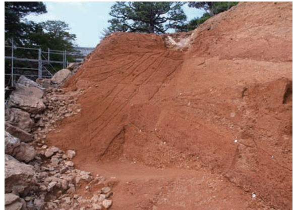
写真40 三ノ丸南面の石垣盛土断面
