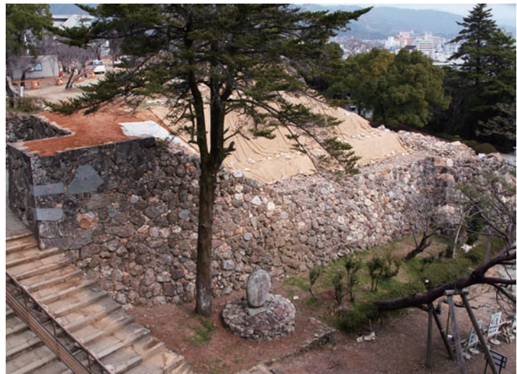
写真44 修築後の三ノ丸南面石垣全景
