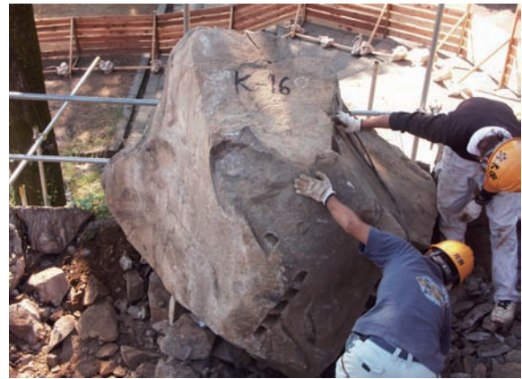
写真42 鉄門石垣に残る矢穴痕
