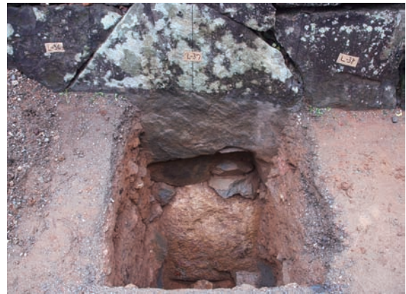
写真43 鉄門石垣の根石(チャート)
