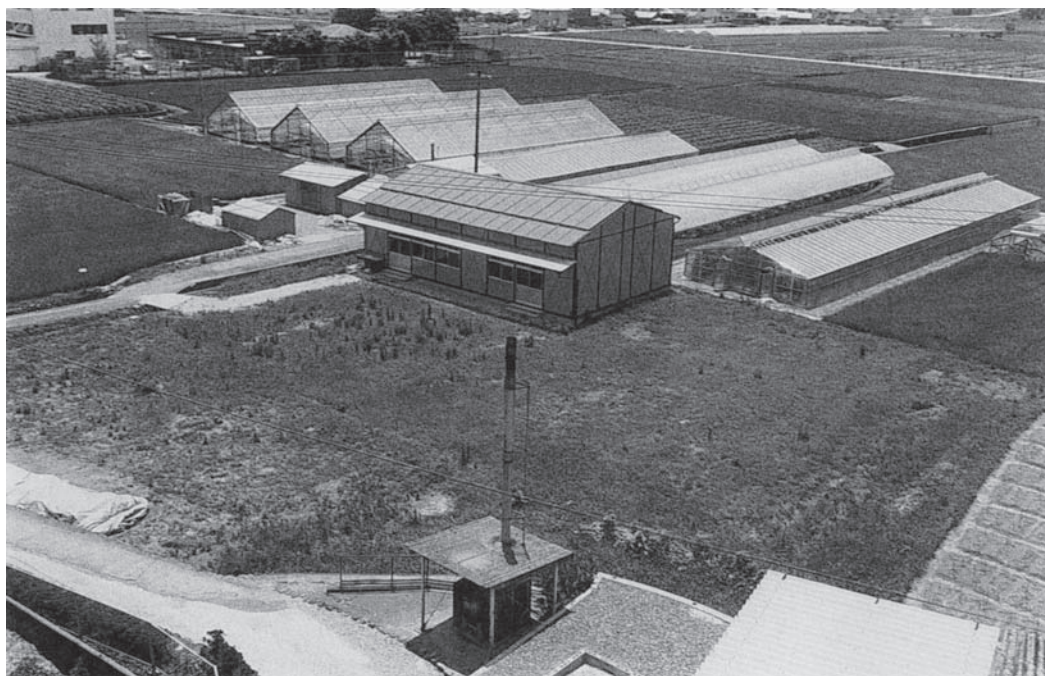
調査前の全景（北西から）
