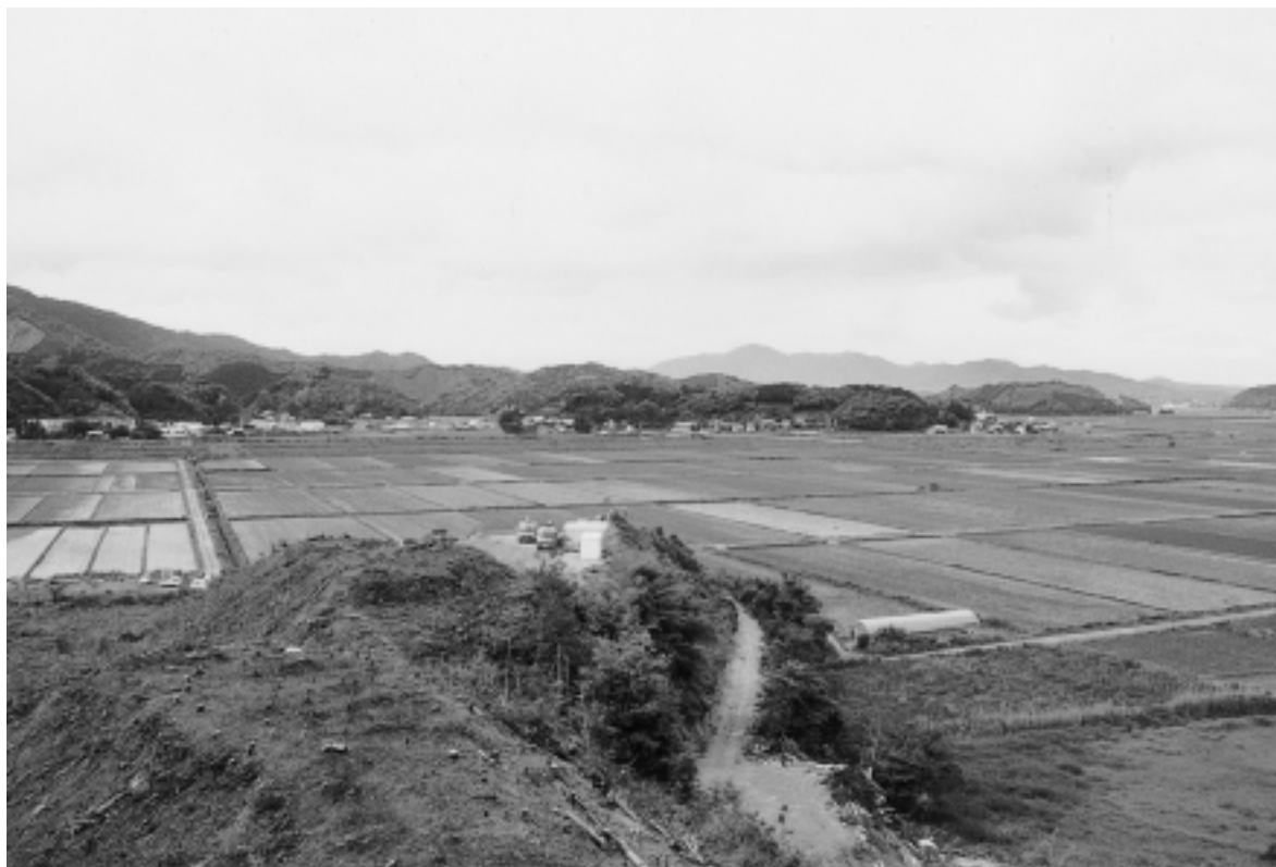
堀切掘削前と作業状況（西より）
