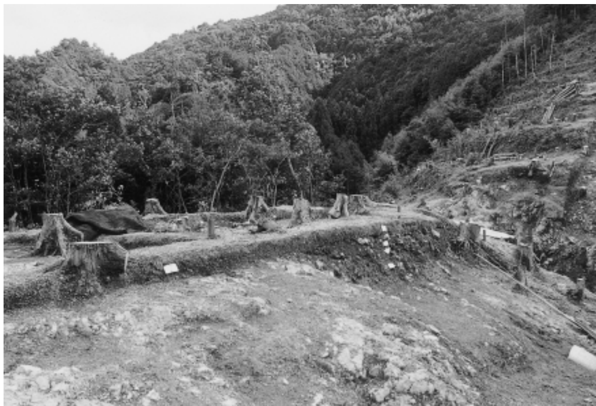
曲輪3 平坦部掘削状況
