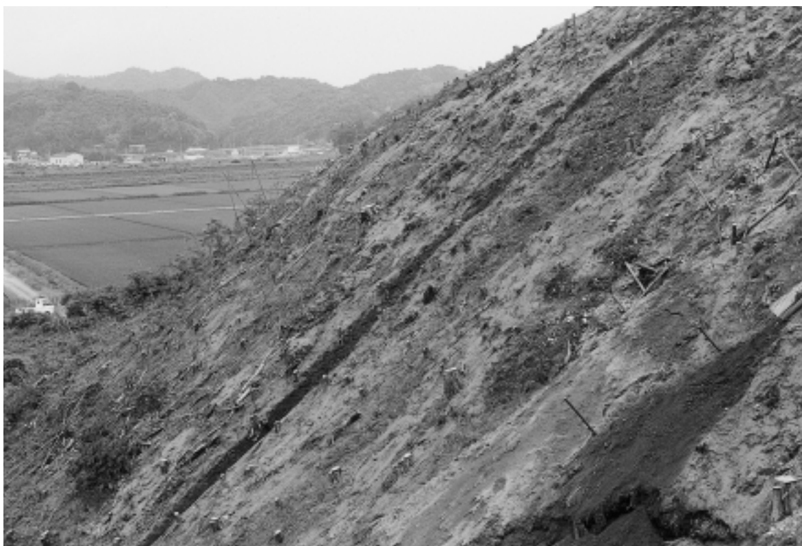
曲輪 2 西斜面部トレンチ
