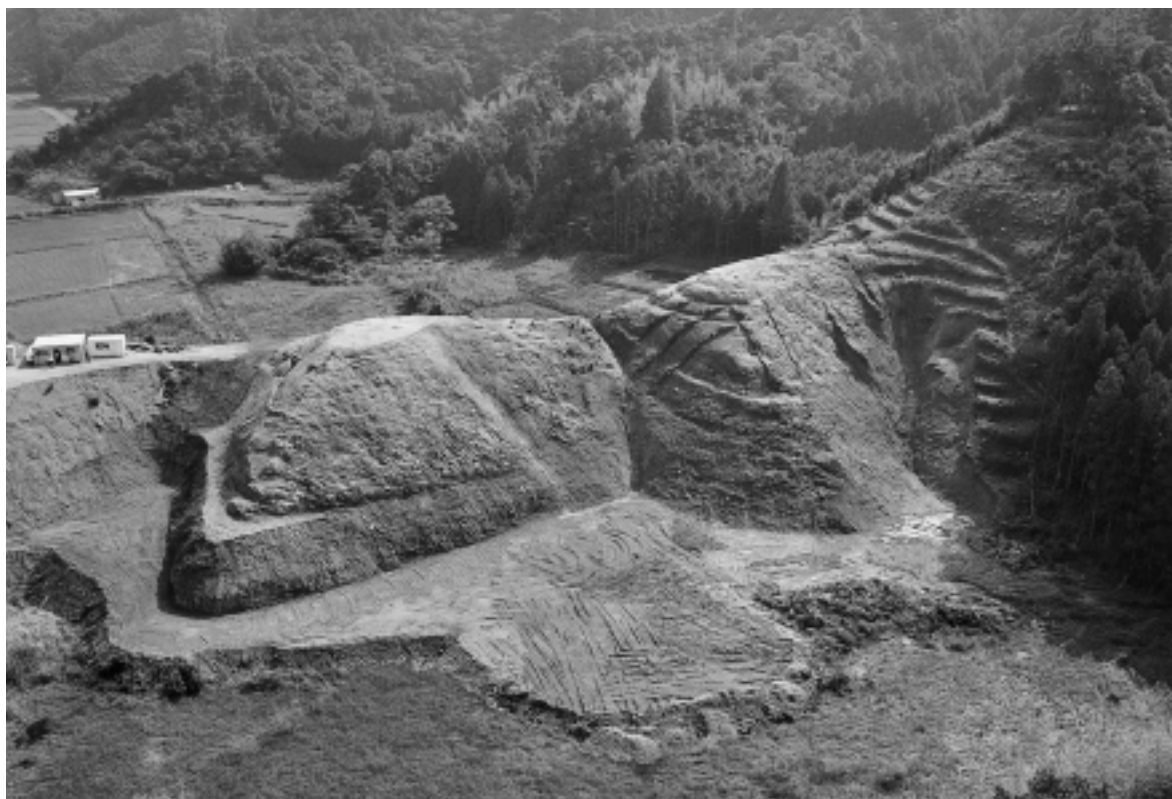
完掘状況（西より）
