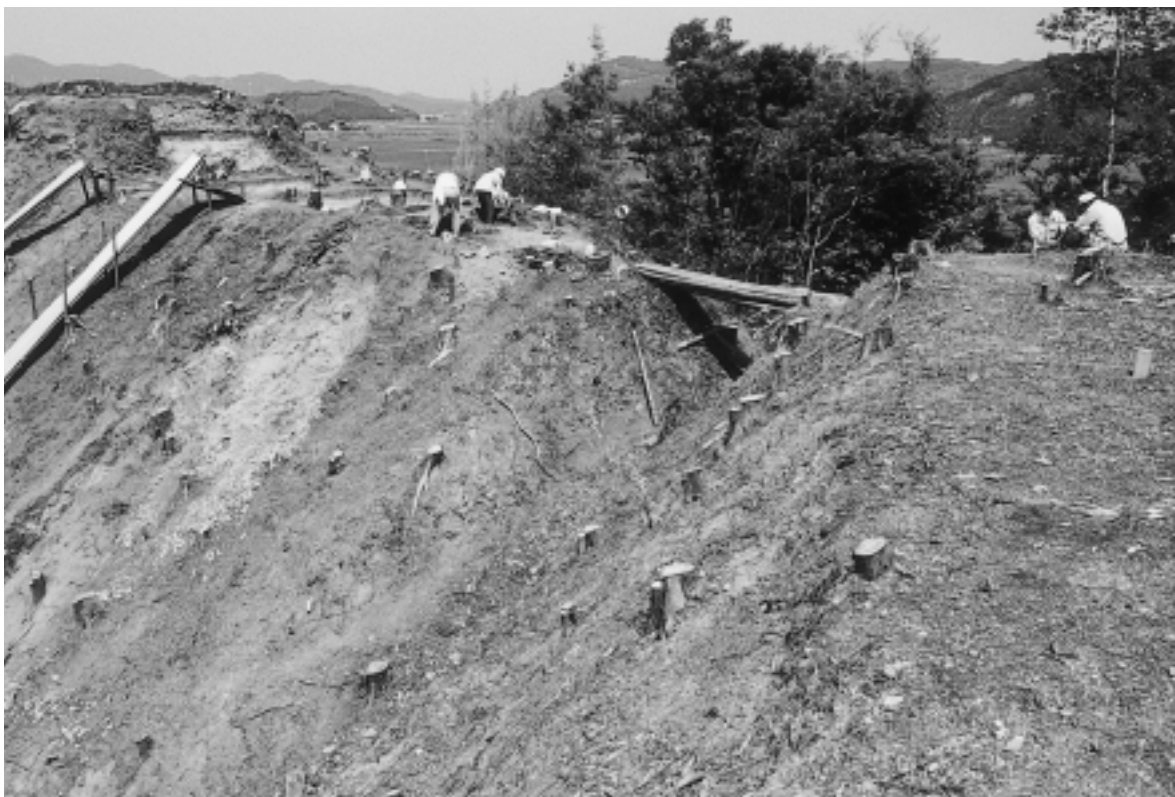
堀切掘削前景と作業風景
