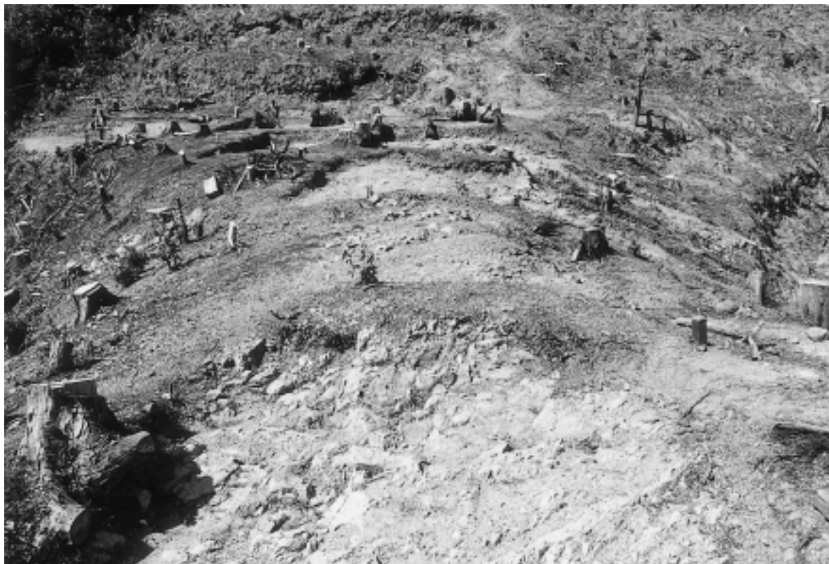
曲輪 1 掘削状況
