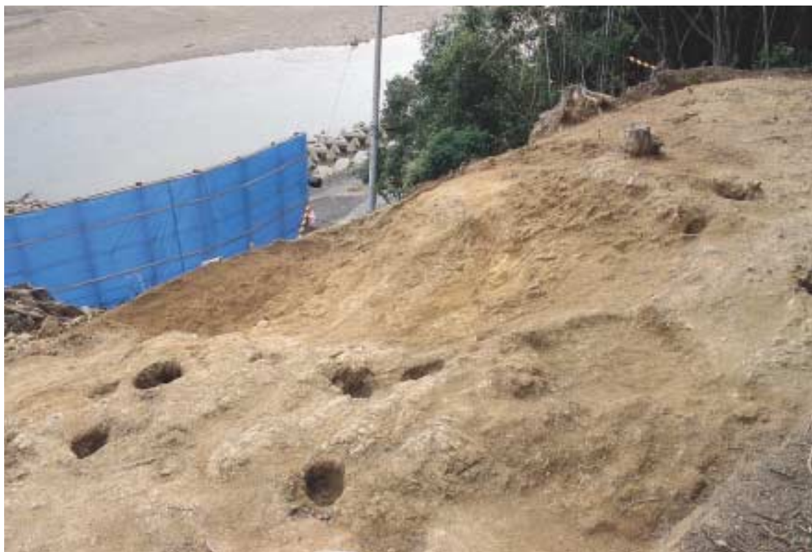
曲輪1 掘立柱建物 ・ 竪堀2 完掘状況
