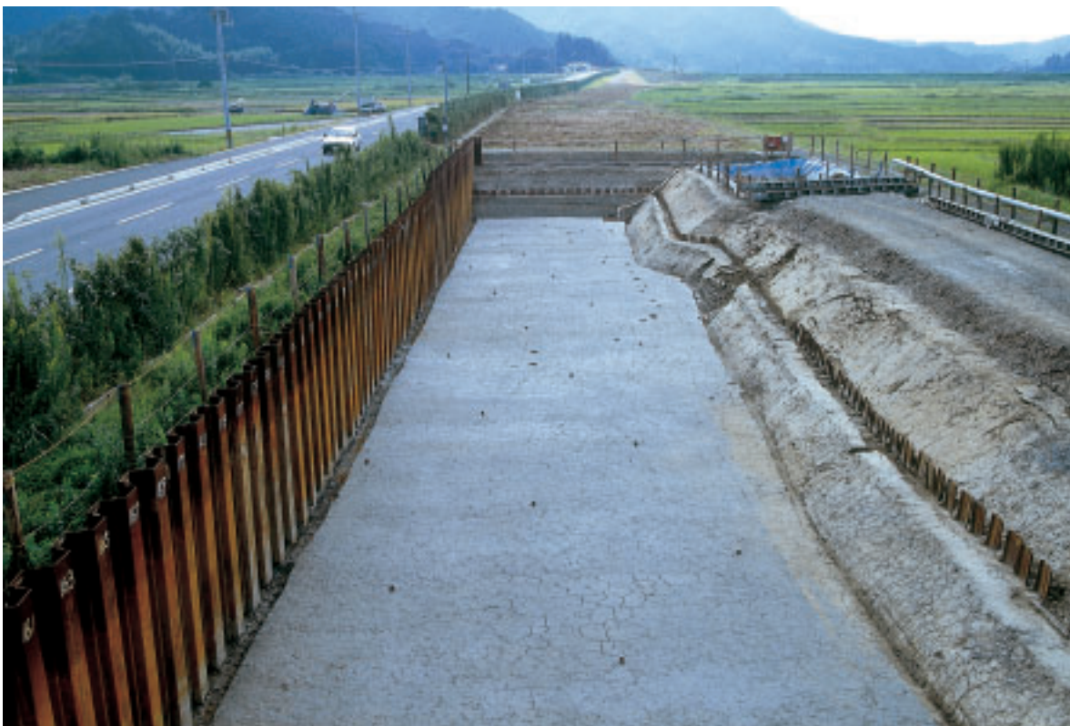
西部第Ⅷ層完掘状態(東より)
