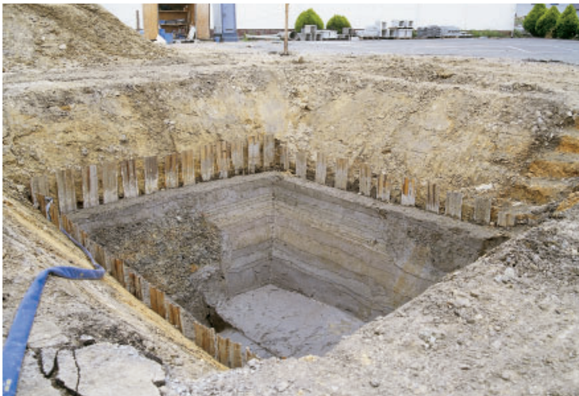
TR-2完掘状態(南東より)
