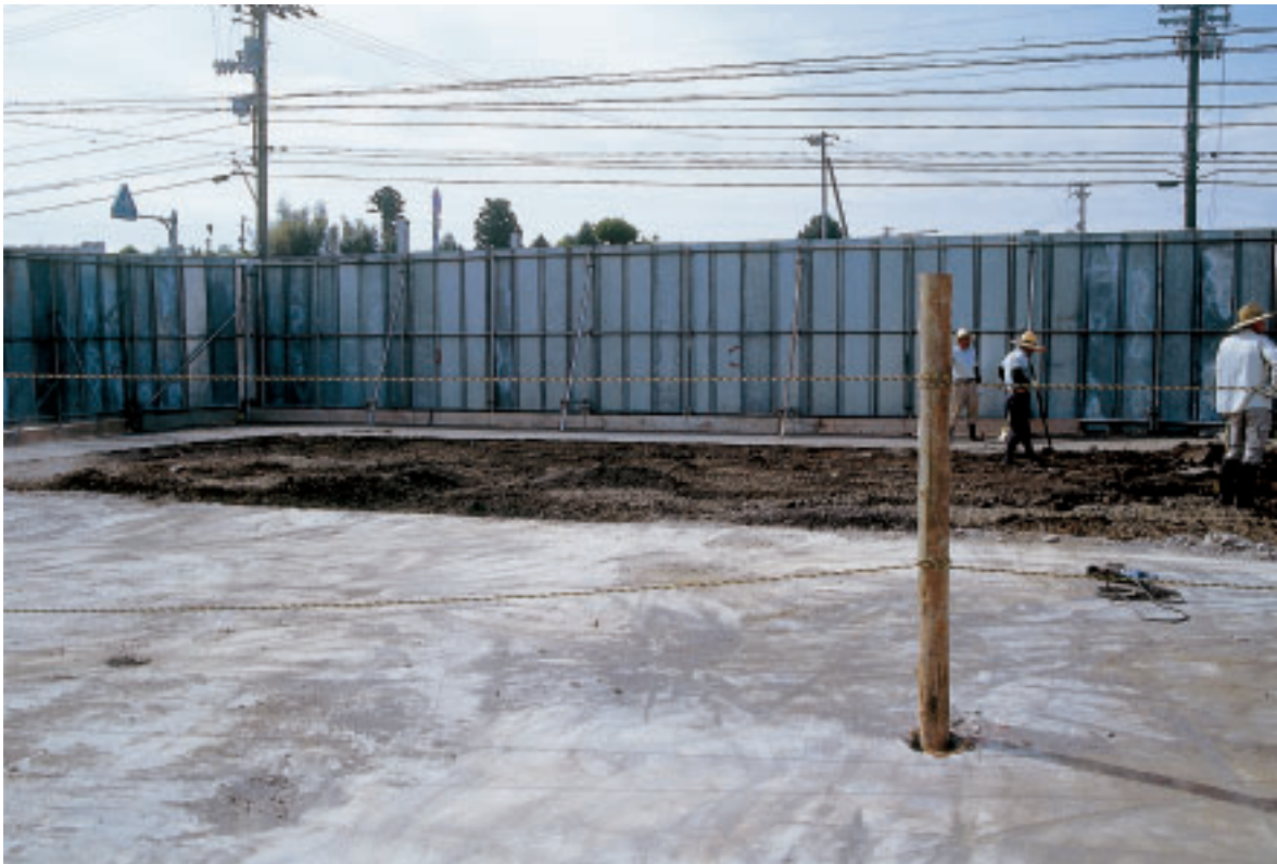
調査前風景(北より)
