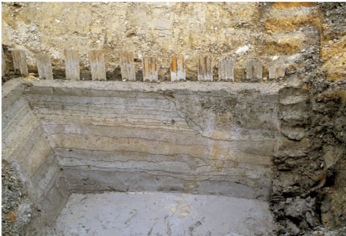
TR-2北壁セクション(南より)
