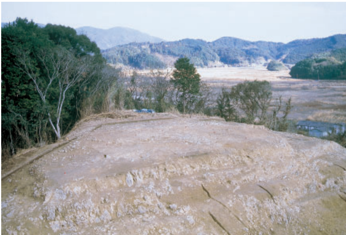
平場検出状態(南西より)
