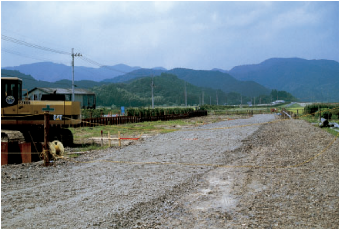
調査前風景(北東より)
