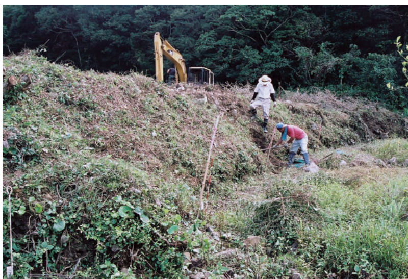
15-1 3区斜面(1)・調査前・東より
