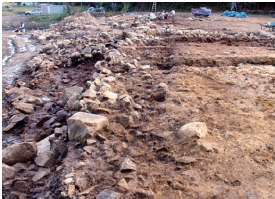
28-3 3C区基壇裏込め・西より
