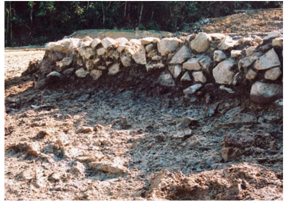
28-2 3C区基壇北壁・北西より
