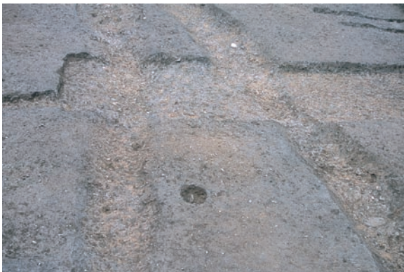
SD11・12 完掘状態(東より)
