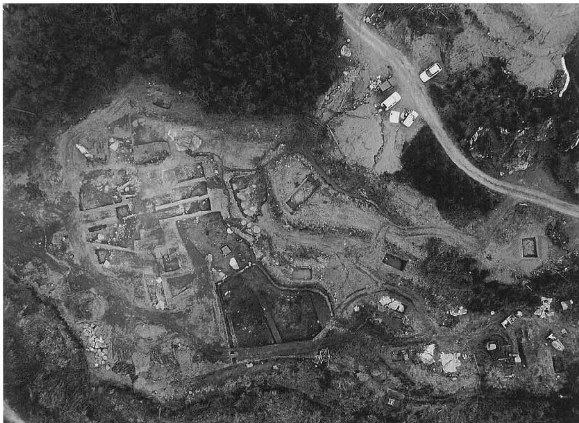
Ⅲ区 全景（上空から）
