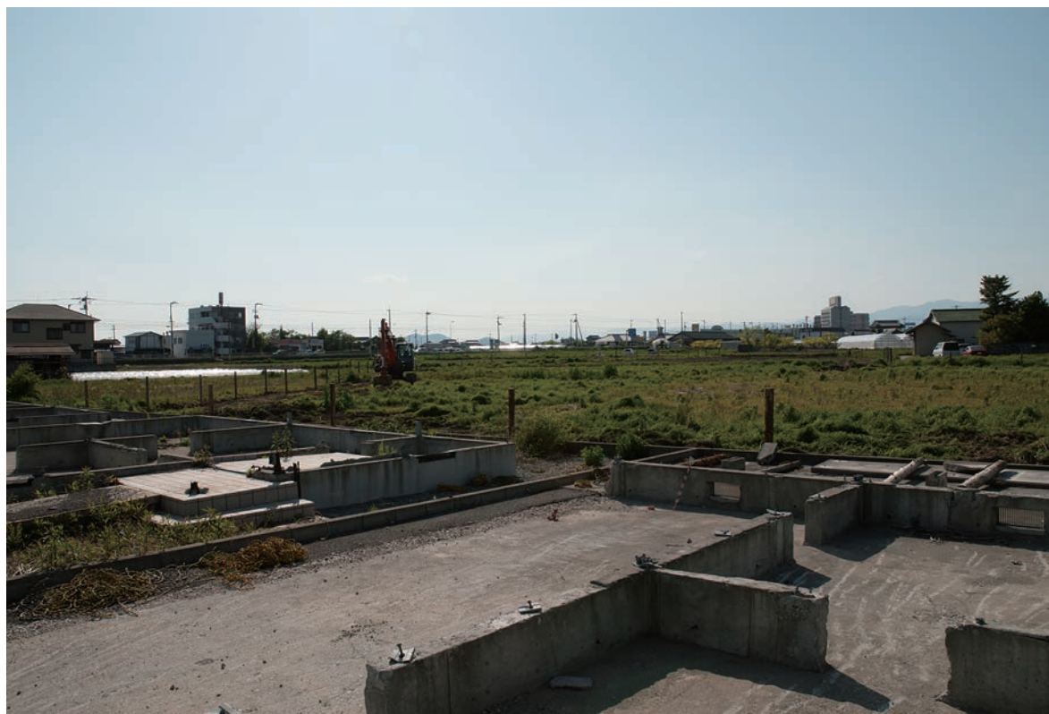
調査前風景(北東より)
