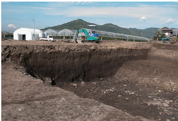
I F-2区 SR1バンクセクション(南東より)
