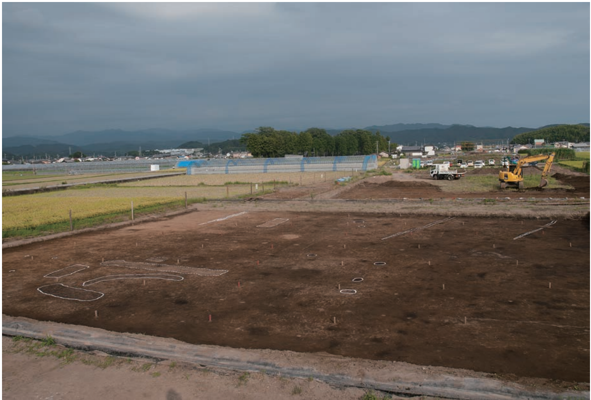
ⅡB区 東部遺構検出状態(西より)
