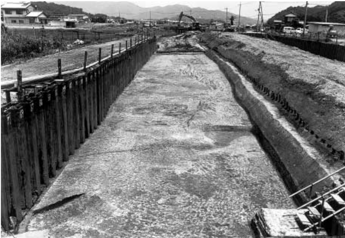
区完掘状態(西より)
