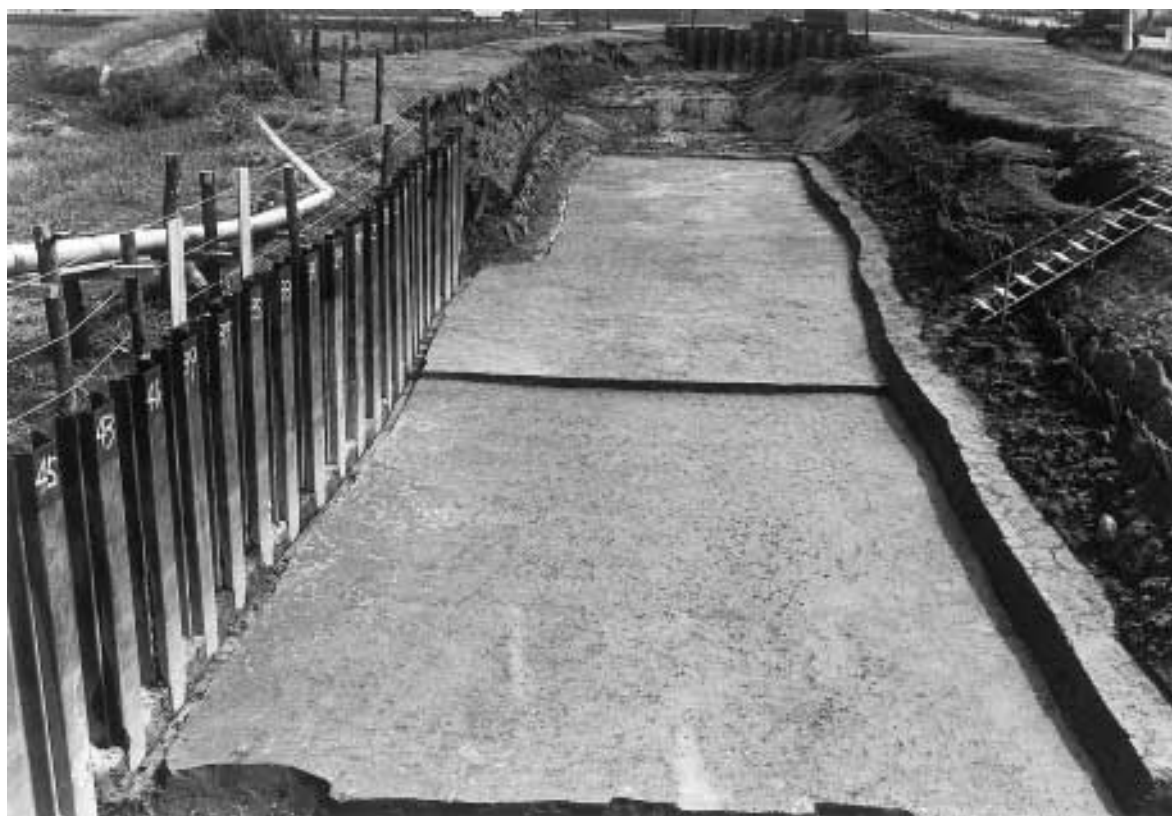
区完掘状態(西より)
