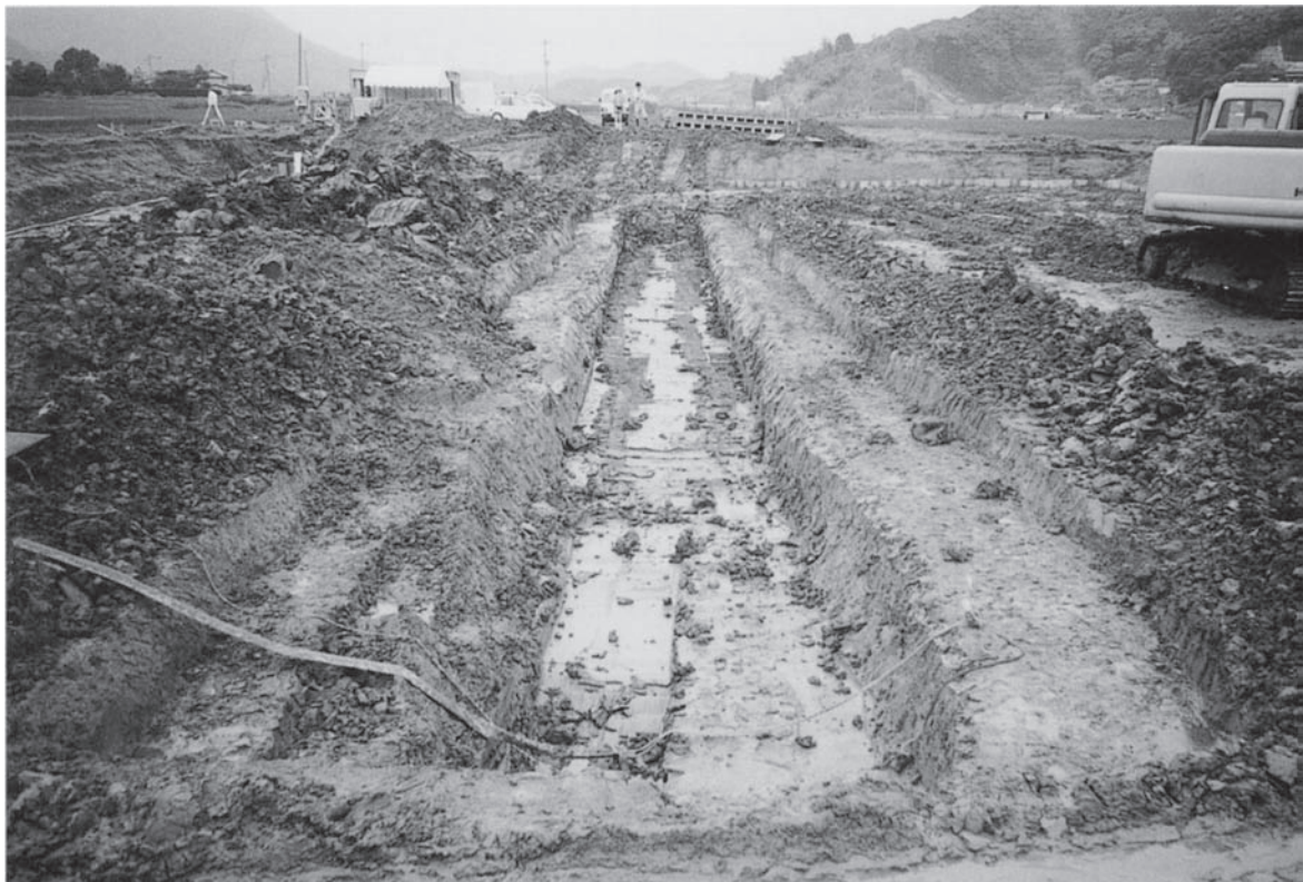
調査区中央トレンチ掘削状況（同上）
