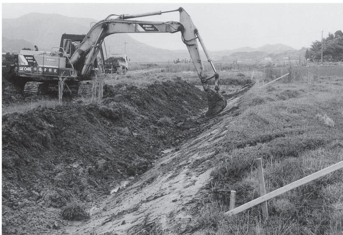
調査前土層掘削状況（東より）
