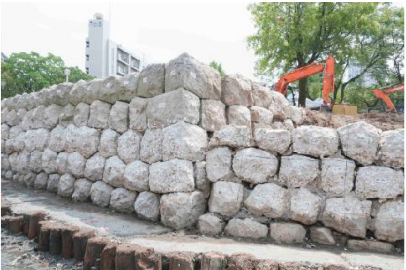
背面石垣および護岸築石検出風景（E区・F区）
