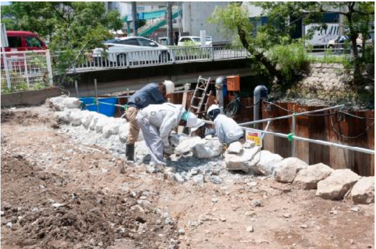
練積み部分解体作業風景
